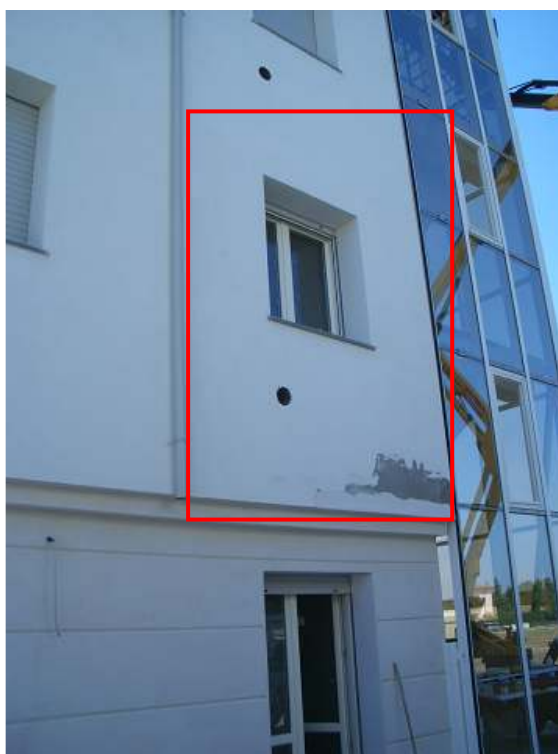
Foto esterne di alcune facciate analizzate
