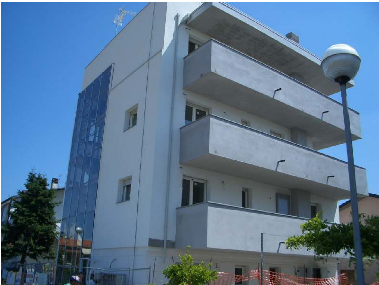
Foto esterna dell'edificio analizzato
